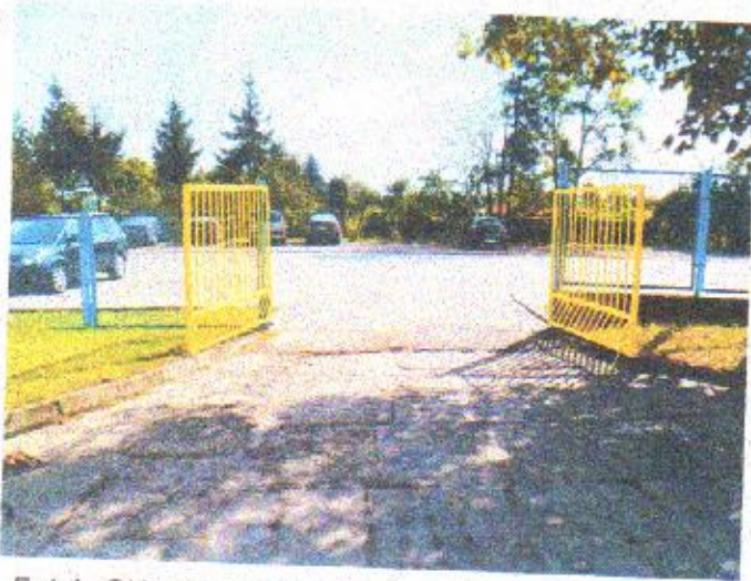
Fot. 1 Główna brama wjazdowa i nawierzchnia z płyt JOMB
