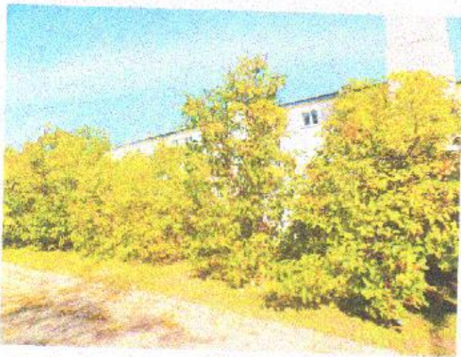
Fot. 5 Zarośla zasłaniające ogrodzenie - do usunięcia
