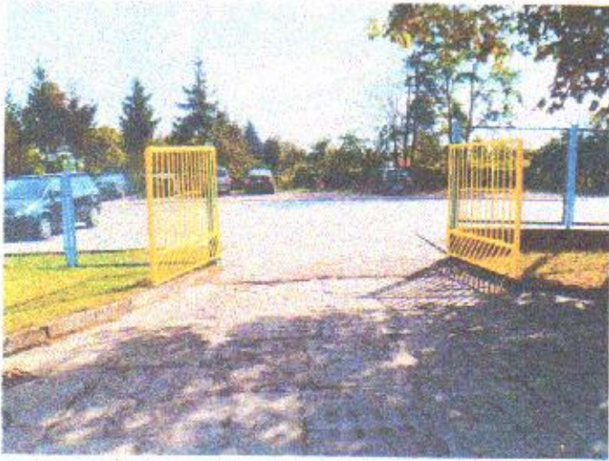
Fot.1 Główna brama wjazdowa i nawierzchnia z płyt JOMB
