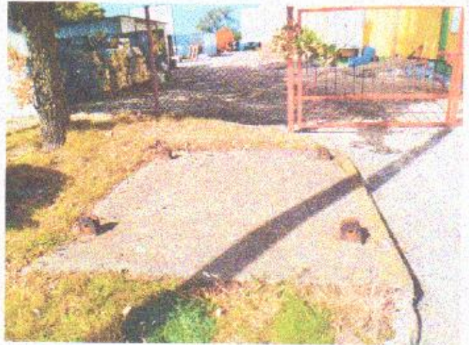
Fot.2 Brama wjazdowa. Fundament słupa do rozbiórki
