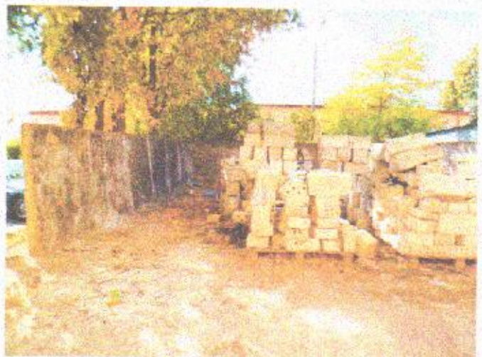
Fot. 6 Ogrodzenie wewnętrzne - murek oporowy (materiały do usunięcia)
