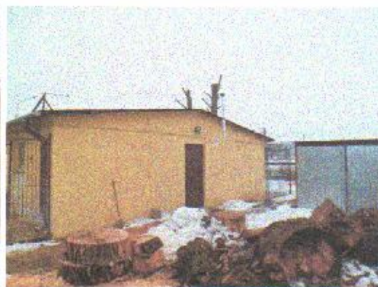
Fot.2 Elewacja północno - wschodnia od zaplecza
