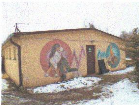
Fot.1 Elewacja południowo - zachodnia frontowa
