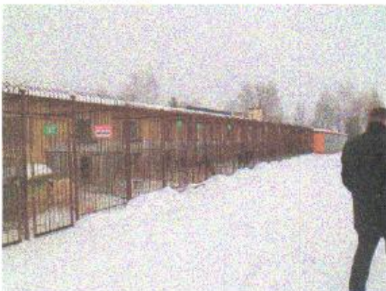
Fot.3 Elewacja północno - zachodnia od PKP
